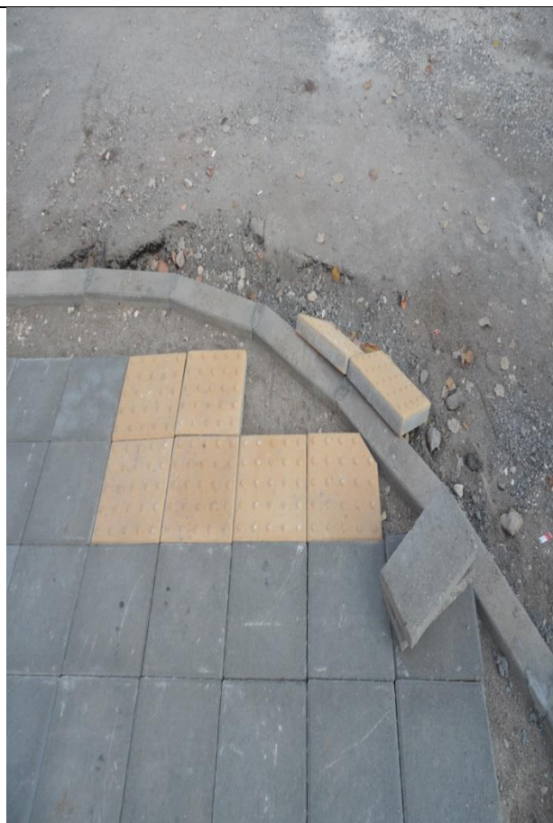
Fig. 57 Tactile indicators on renewed sidewalk /. Тактилни индикатори на подновен тротоар
