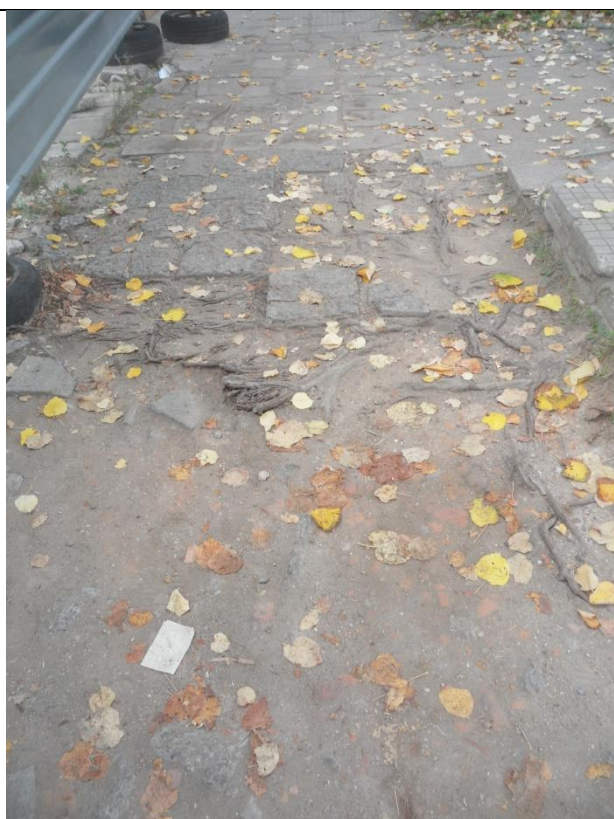
Fig. 20 Broken sidewalk flooring / Нарушена тротоарна настилка
