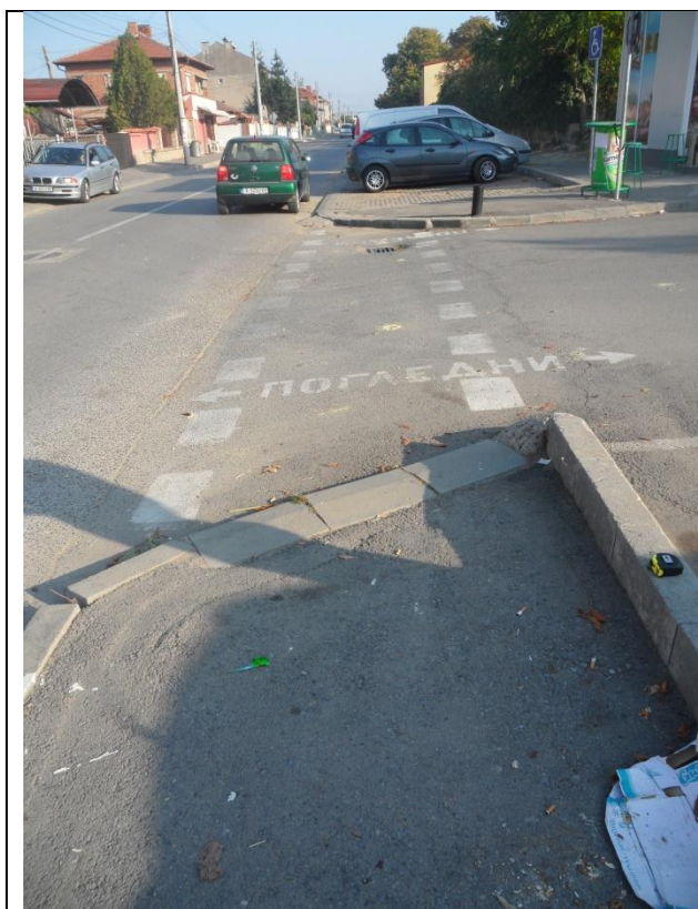
Fig. 31 Bevel, crosswalk, and parking space for disabled people / Скосяване, пешеходна пътека и парко място за инвалиди
