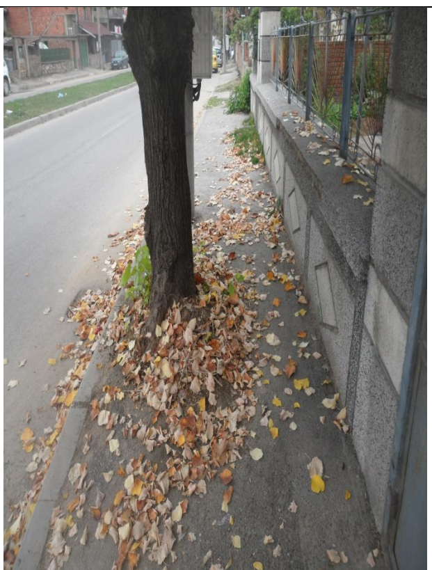
Fig. 52 Reduced sidewalk width by vegetation /. Намалена ширина на тротоара от разстителност
