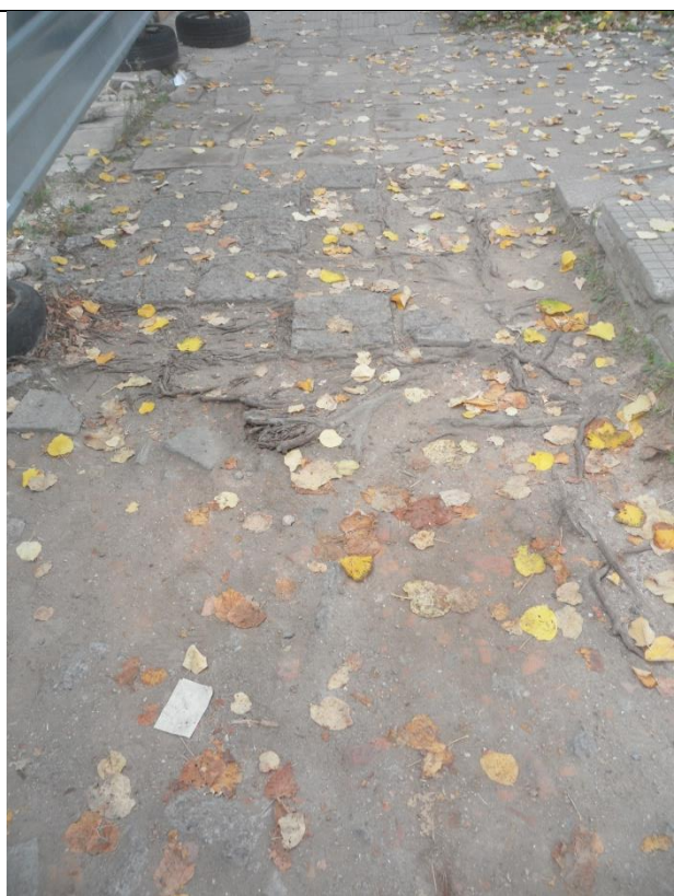
Fig. 20 Broken sidewalk flooring / Нарушена тротоарна настилка
