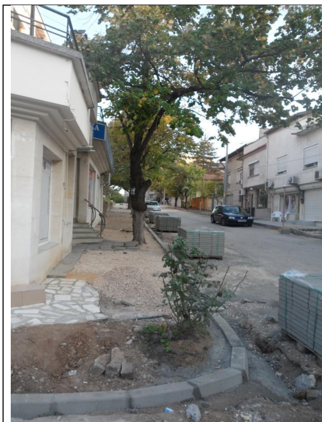
Fig. 55 Renewal of existing sidewalk /. Подновяване на съществуващ тротоар
